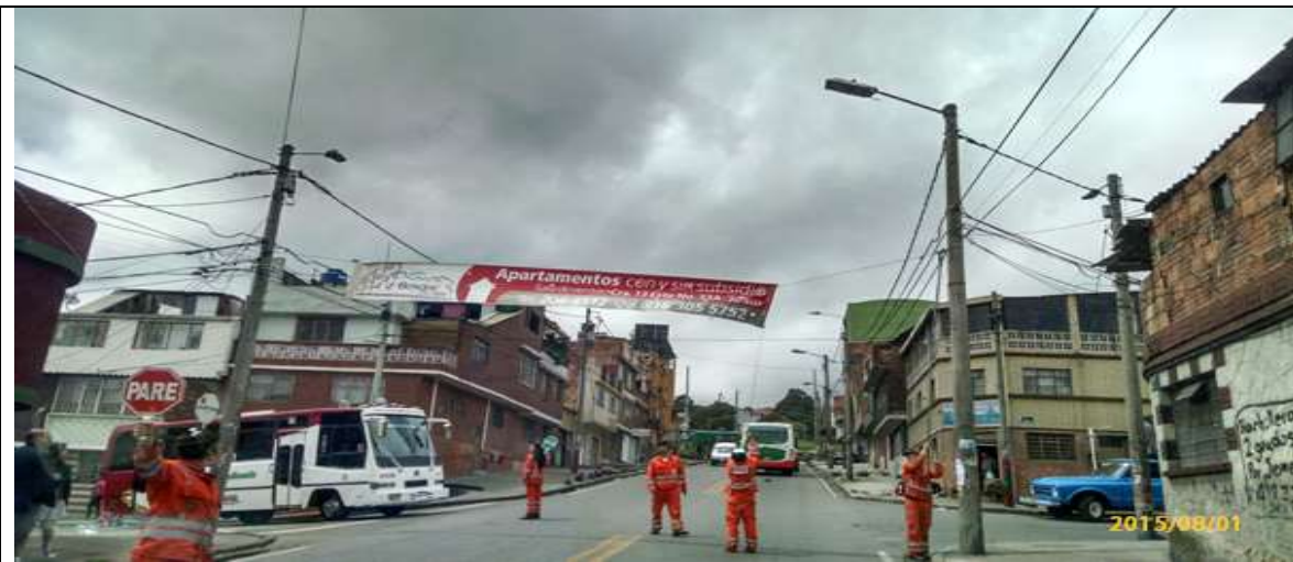
Fotografía No. 4. Elementos instalados en Espacio Público. Operativo en la Localidad de San Cristóbal, día 01 de Agosto de 2015. Pasacalle desmontado sobre la Calle 34 Sur con Carrera 7.
