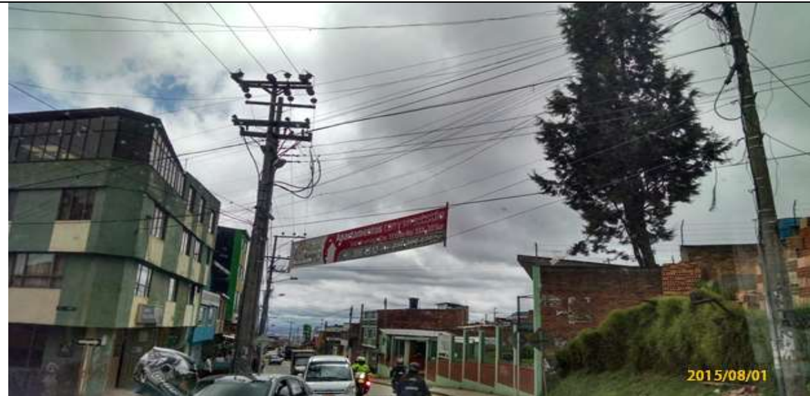
Fotografía No. 18. Elementos instalados en Espacio Público. Operativo en la Localidad de San Cristóbal, día 01 de Agosto de 2015. Pasacalle desmontado sobre la Carrera 12 Este con Calle 34 Sur.
