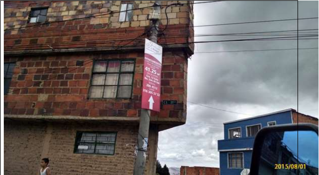
Fotografía No. 21. Elementos instalados en Espacio Público. Operativo en la Localidad de San Cristóbal, día 01 de Agosto de 2015. Pendón desmontado sobre la Avenida Carrera 31 Sur con Calle 31 A Sur.
