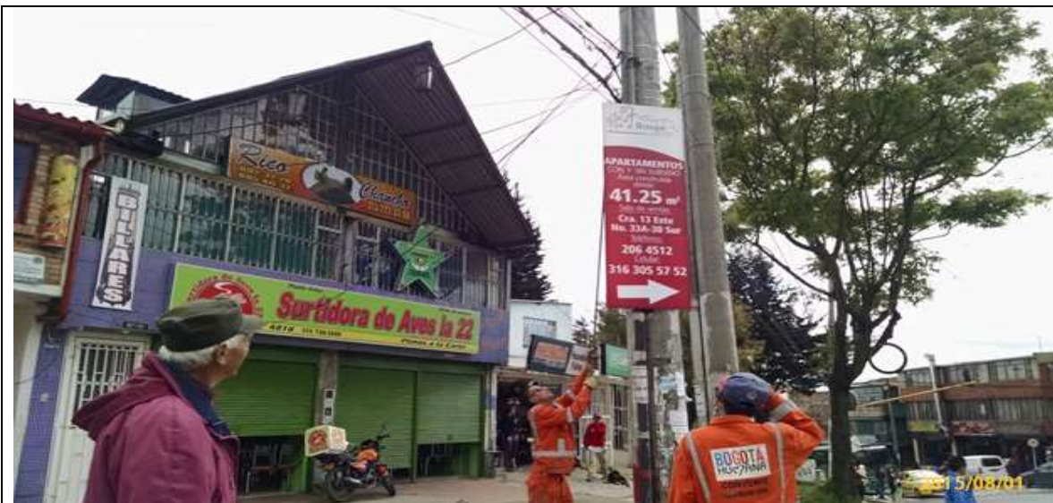
Fotografía No. 16. Elementos instalados en Espacio Público. Operativo en la Localidad de San Cristóbal, día 01 de Agosto de 2015. Pendón y pasacalle desmontados sobre la Carrera 12 Este con Calle 36 M Sur.
